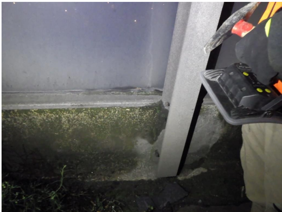
Photo 12 : joint dégradé panneau 118 en voie rapide
