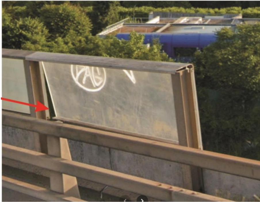
Photo 9 : absence de fixation – 1 er écran de la 2 ème série en BAU
