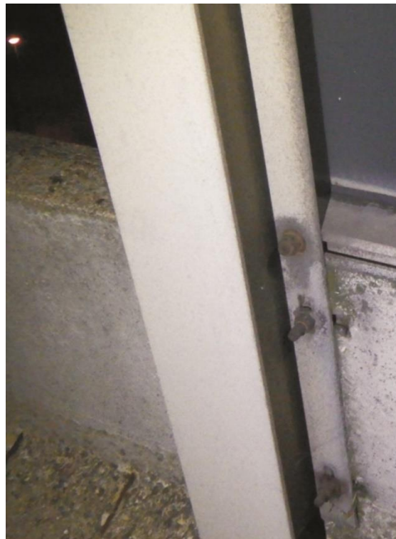
Photo 8 : oxydation des fixations
