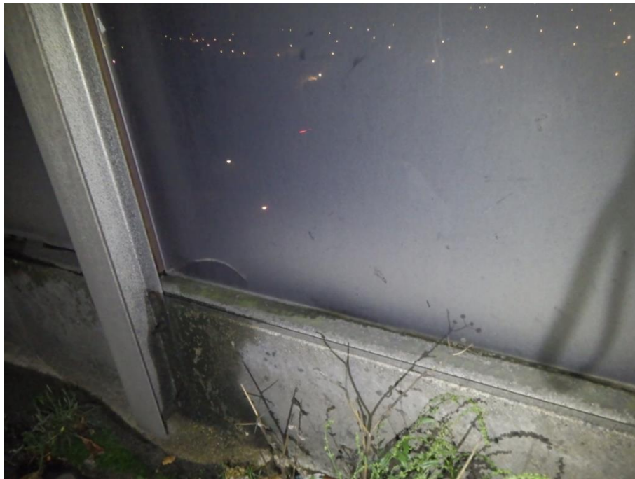
Photo 11 : panneau fissuré, écran 117 en voie rapide
