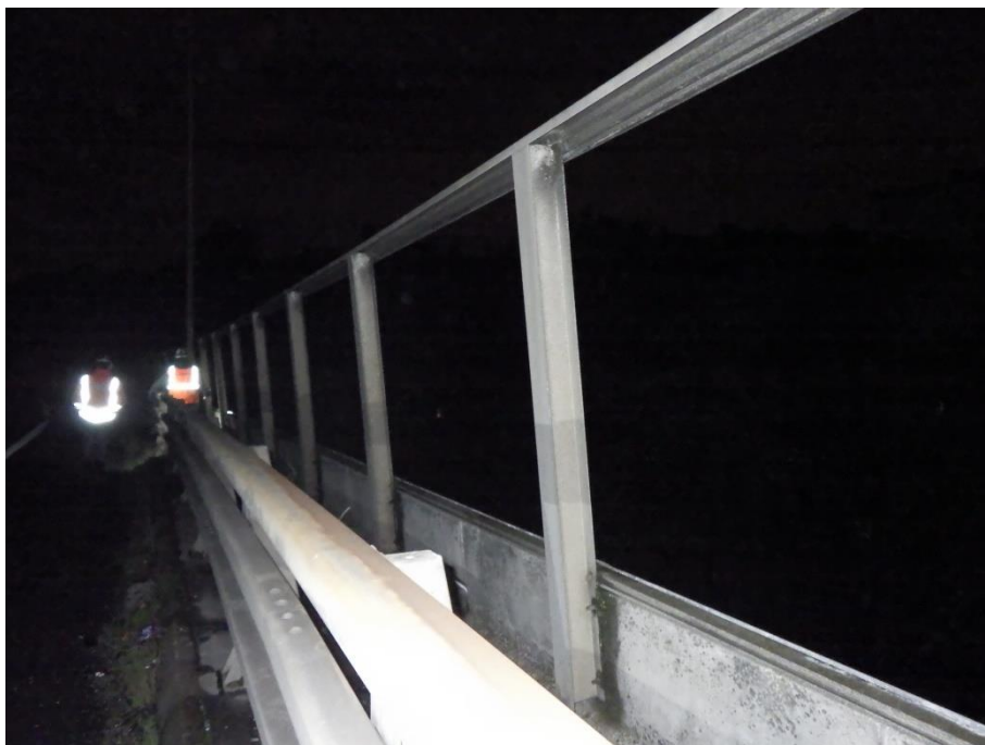
Photo 14 : panneaux absents en BAU (2 e série)
