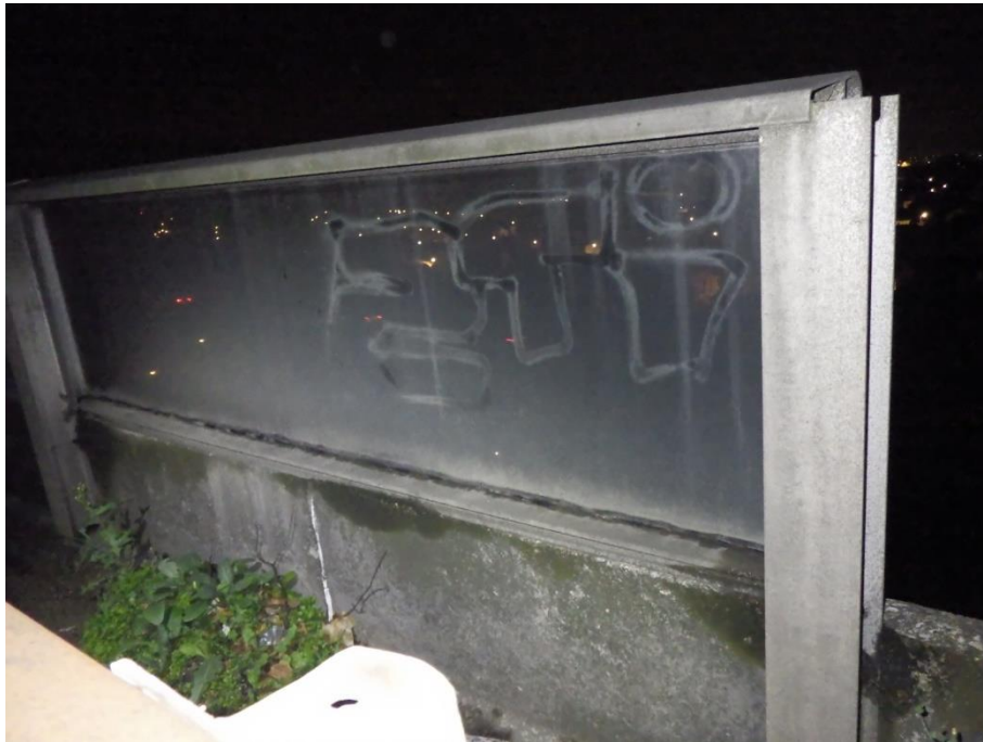
Photo 13 : joint dégradé panneau 139 en voie rapide
